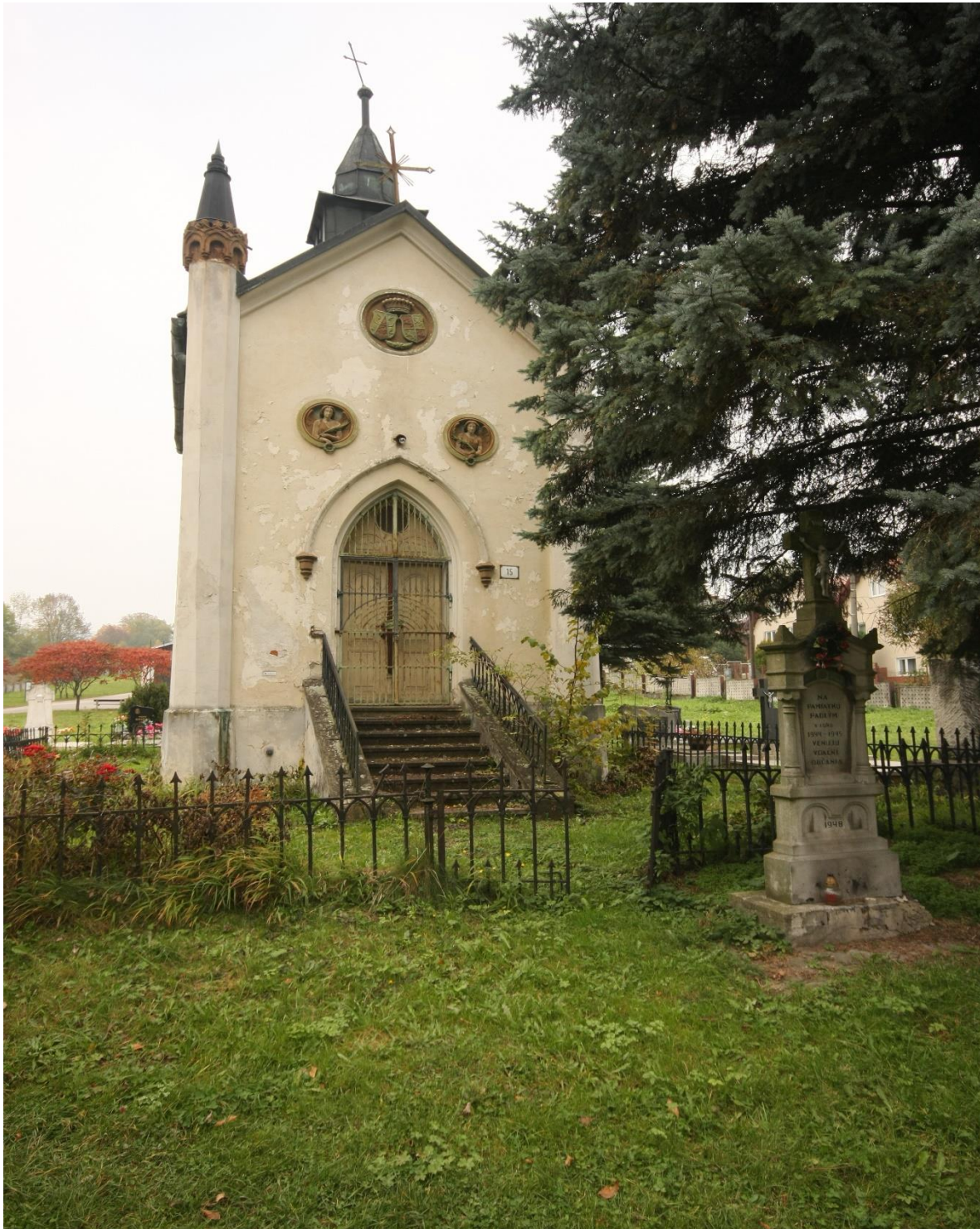
Kaplnka pred rekonštrukciou
