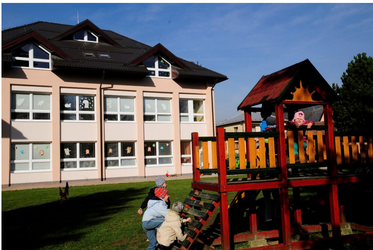
Budova MŠ po rekonštrukcii
