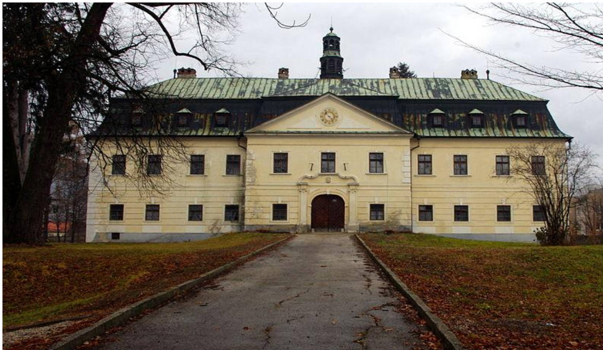
Budova pred rekonštrukciou
