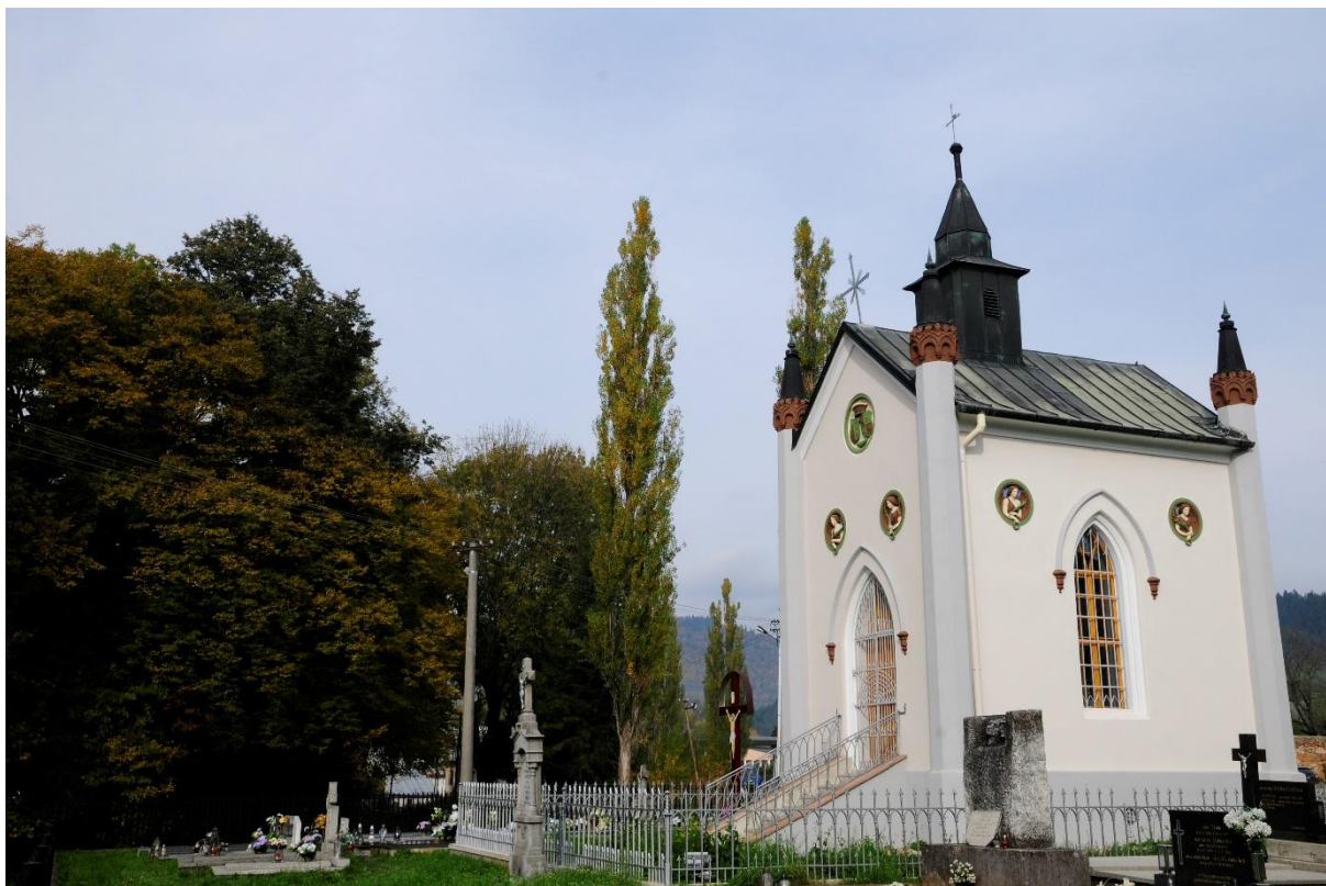
Zrekonštruovaná kaplnka na cintoríne
