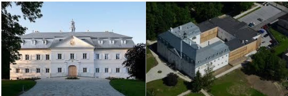
Hotel po rekonštrukcii
