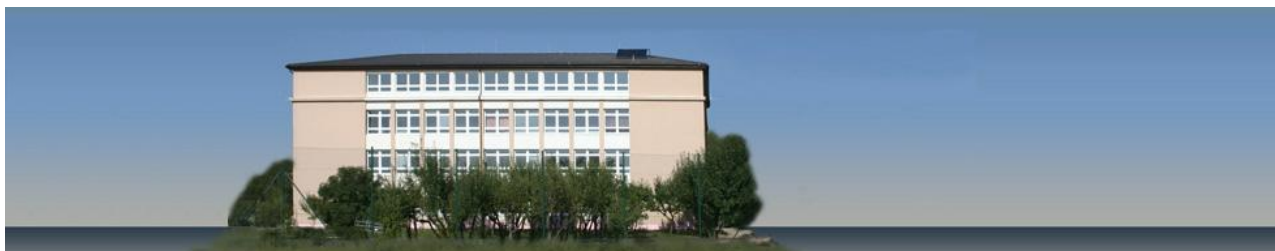
Budova ZŠ Gbeľany po rekonštrukcii- rok 2011
